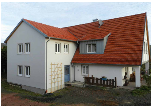
Beispiel für eine gelungene Sanierung in Sandberg (Preisträger 2022) Foto: Martin Rosenberger
